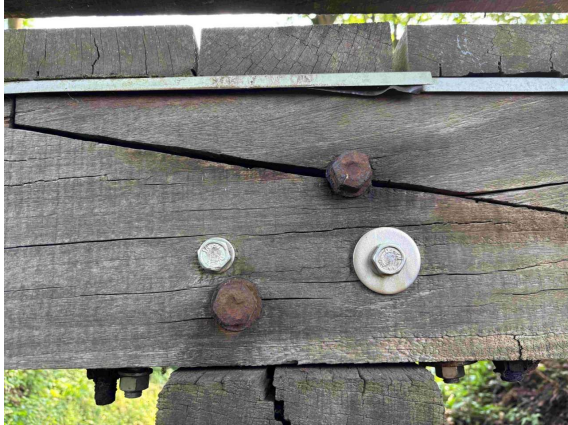
2025 LÄNGSTRÄGER STOBSTELLE MIT VERBINDUNGSMANGEL
