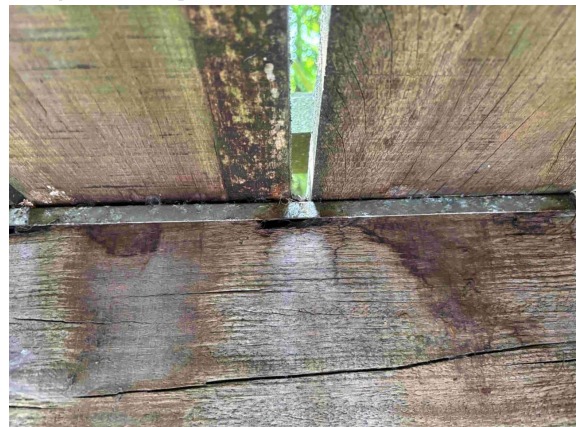
2025 LÄNGSTRÄGER PILZBEFALL MIT QUERSCHNITTSVERLUST
