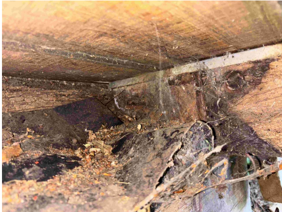
2025 AUFLAGERWINKEL KORROSION
