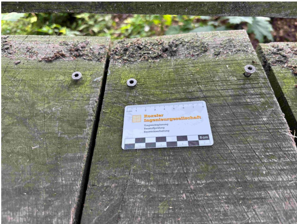
008 - ZU SCHADEN 27 - NICHT KRAFTSCHÜSSIGE BOHLENVERBINDUNG
