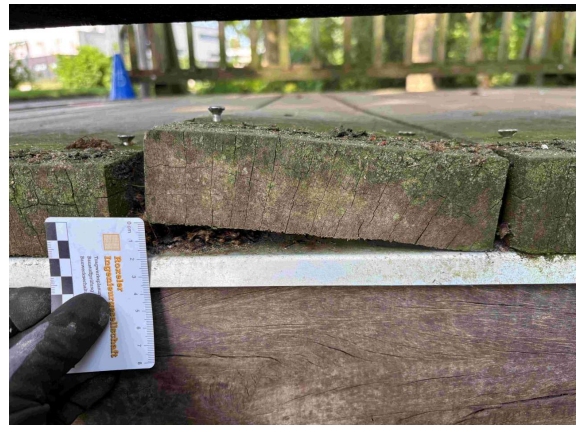
2025 BOHLENBEFESTIGUNG LOSE
