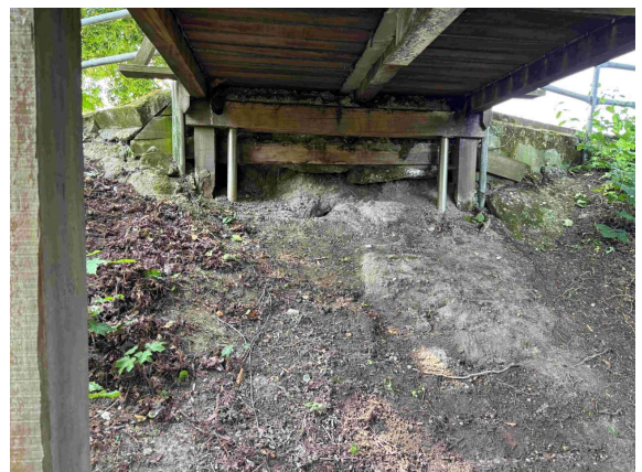
2025 ERDBERÜHRTE AUFLAGERBAUTEILE
