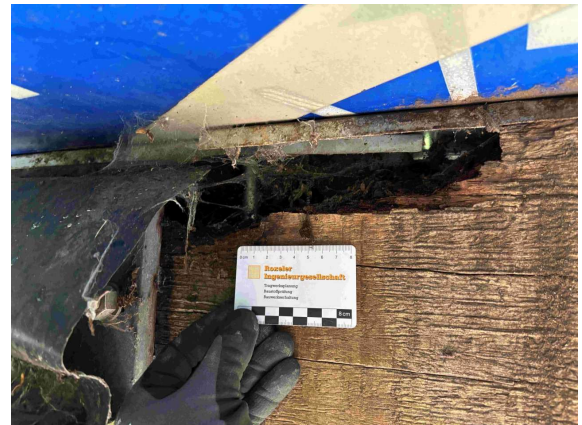
2025 LÄNGSTRÄGER DURCHFEUCHTET & QUERSCHNITTSSCHWÄCHUNG
