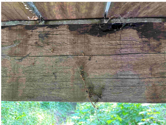
2025 RISS LÄNGSTRÄGER INNEN UNTERLAUF
