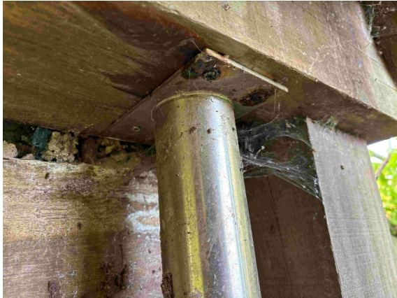
2025 RAMMPFAHL KORROSION
