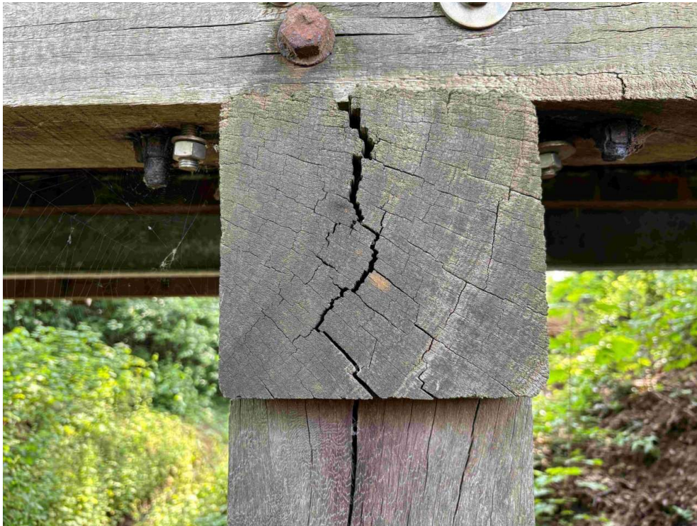
008 - ZU SCHADEN 27 - NICHT KRAFTSCHÜSSIGE BOHLENVERBINDUNG
