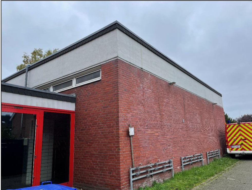
Abb. 8: Östlicher Eingang zum Gerätehaus und den weiteren Räumen
