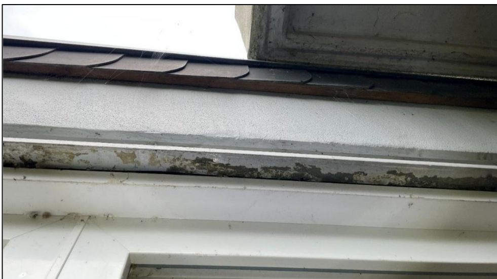
Abb. 11: Geschlossene Attika- und Schindelverblendung des hinteren Gebäudeteils
