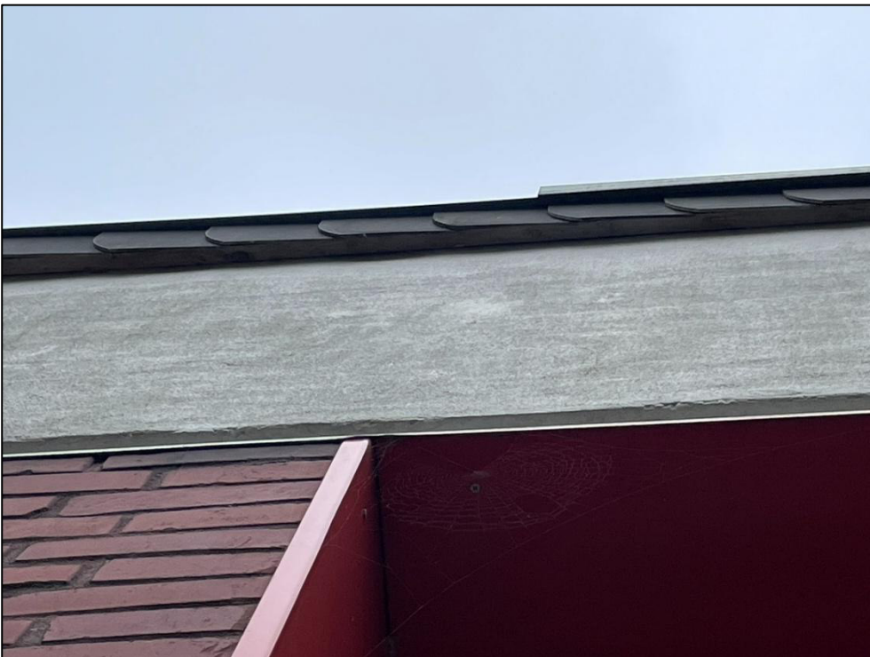
Abb. 7: Geschlossene Attikablende mit Schindelverkleidung
