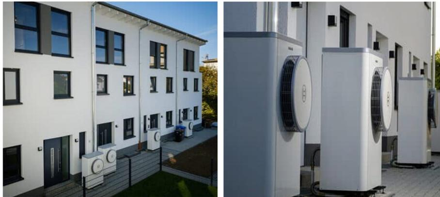
Abbildung 12: Beispielhafte Aufstellung von Außeneinheiten bei einem Reihenhaus<sup>19</sup>
