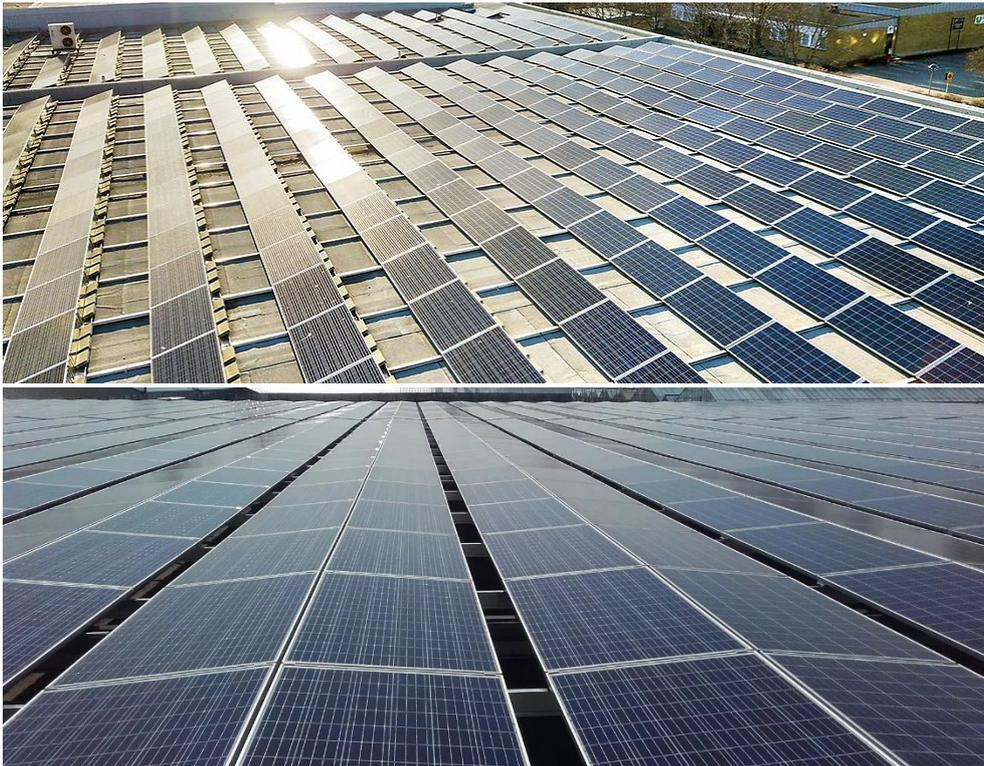
Abbildung 3: Beispielhafte Südausrichtung (oben)<sup>11</sup> und Ost-West Ausrichtung (unten)<sup>12</sup>
