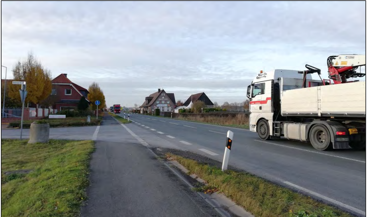
Abbildung 3: Knotenpunkt Appelhülsener Straße (B 525) / Anbindung zum Gewerbegebiet
