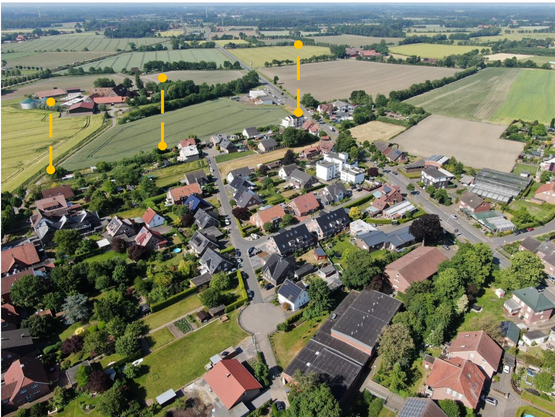
Abb. 5: Schrägluftbild mit Blick auf das südliche Plangebiet (vereinfachte Abgrenzung in orange)
