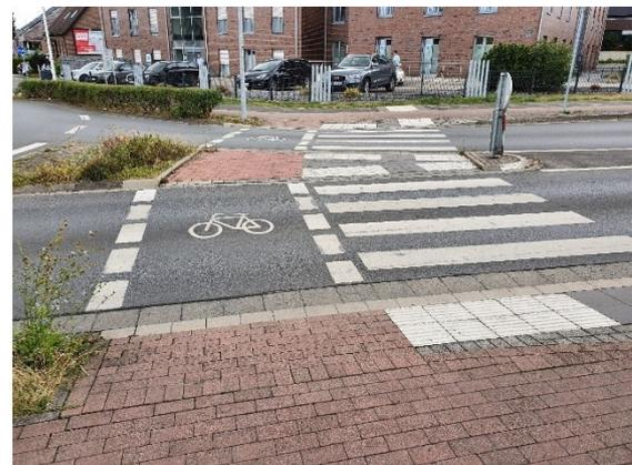
Abbildung 4: Querungsmöglichkeiten in Nottuln (li. nicht-barrierefrei; re. barrierefrei)
