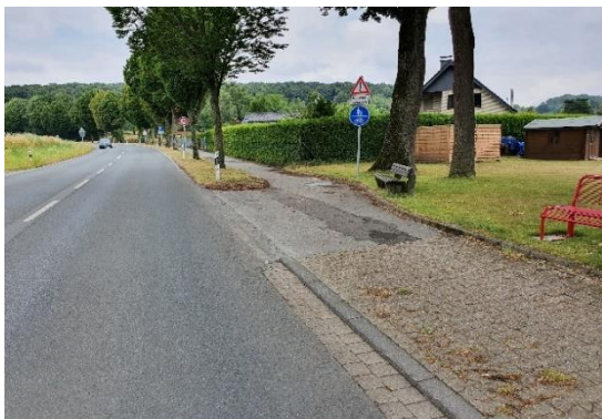
Abbildung 9: Mangelhafte Oberflächenqualität von Radwegen in Nottuln
