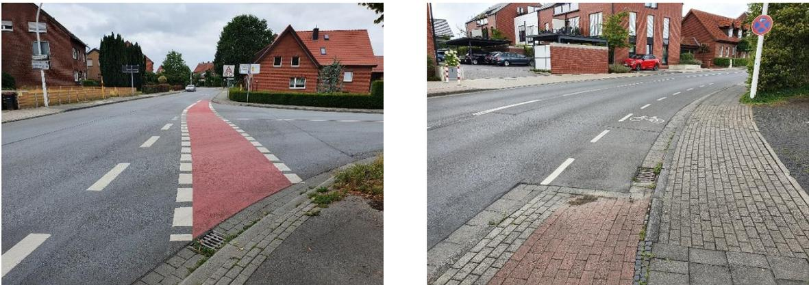
Abbildung 52: Einfädelungshilfe für den Radverkehr auf der Schapdettener Str.
