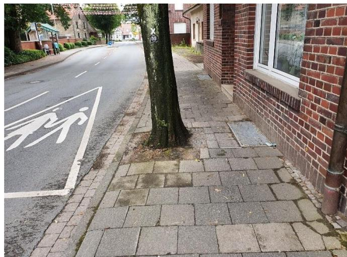
Abbildung 70: Wurzelschäden auf dem Fußweg in Schapidetten
