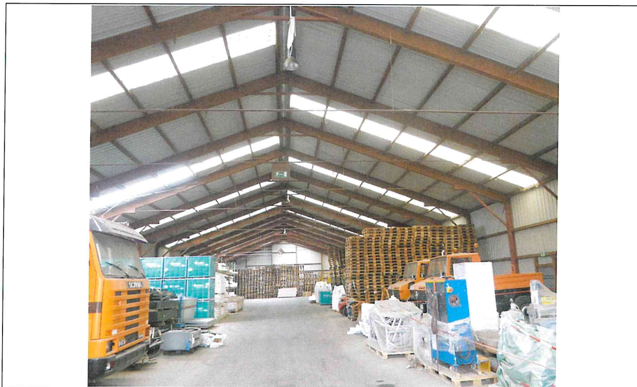
Abb. 4: alte Lagerhalle – Innenansicht
