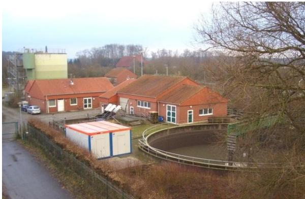
Elemente der modernen Abwasserreinigung mit dem Klärbecken im Vordergrund und dem Faulturm im Hintergrund
