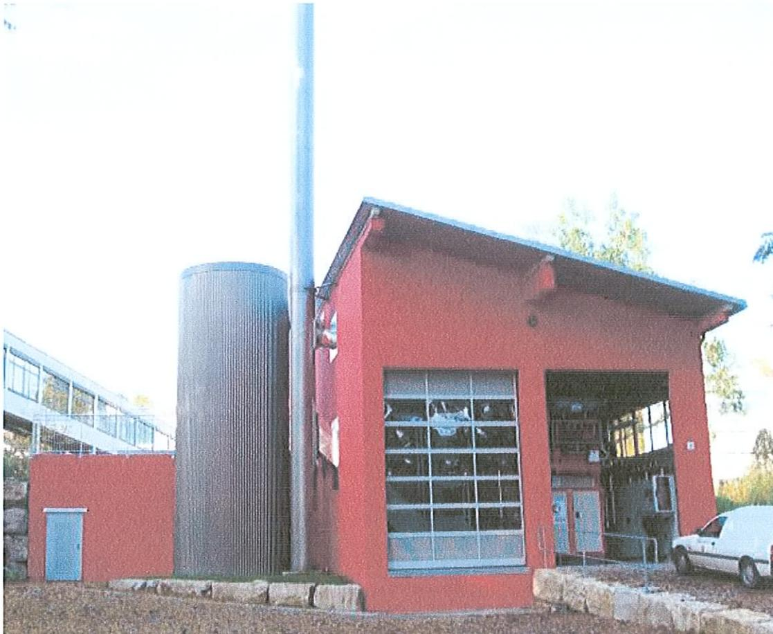
Abb. 15: Heizzentrale Holzsnitzelheizung Gaildorf: 800 kW Holzkessel, 50 m<sup>3</sup> Pufferspeicher
