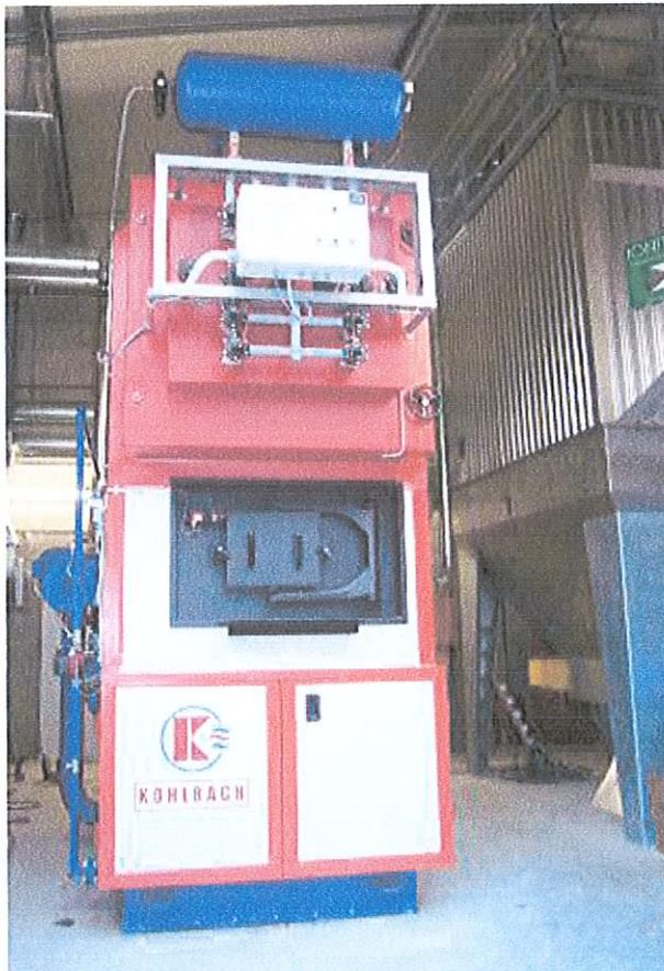
Abb. 17: Holzschneitzkeschel (800 kW) und Elektrofilter
