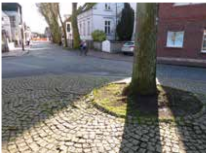
Pflasterung und Baumscheiben an der Alten Amtmannei
