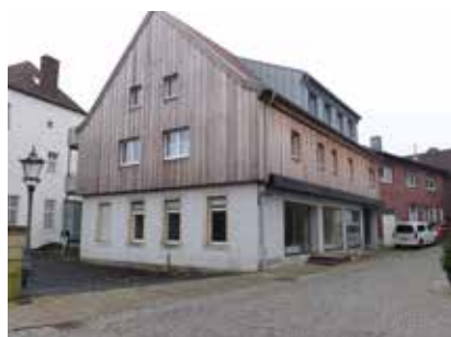
Leerstand Kirchstraße / Kurze Straße
