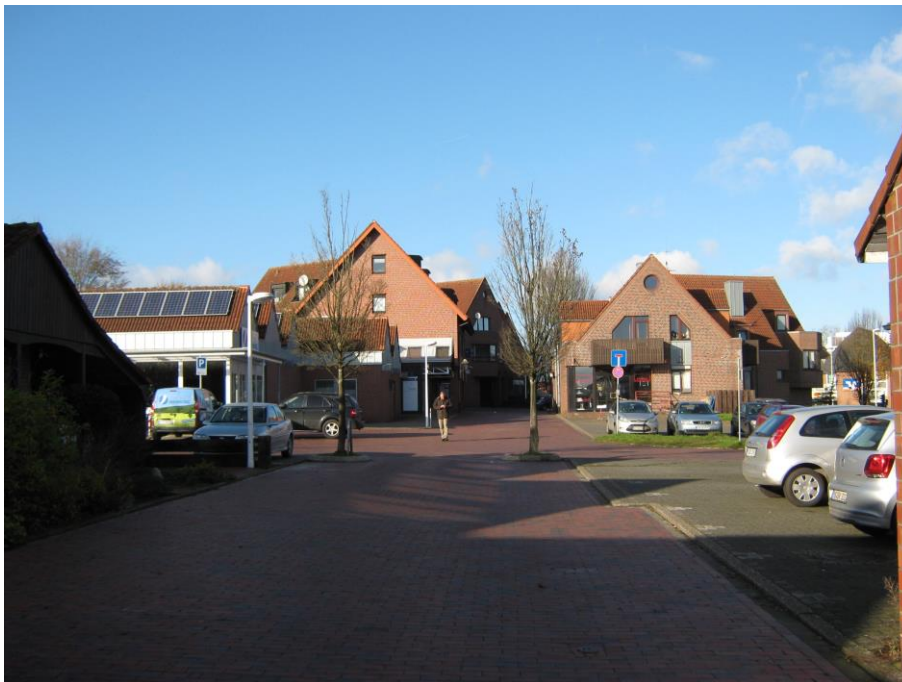
Abb. 20 Martin-Luther-Platz / Martin-Luther-Straße Blick Richtung Ortskern
