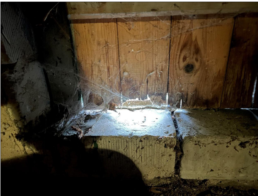
Abb. 15: Passierbare Holztür zum Dachboden des Nebengebäudes
