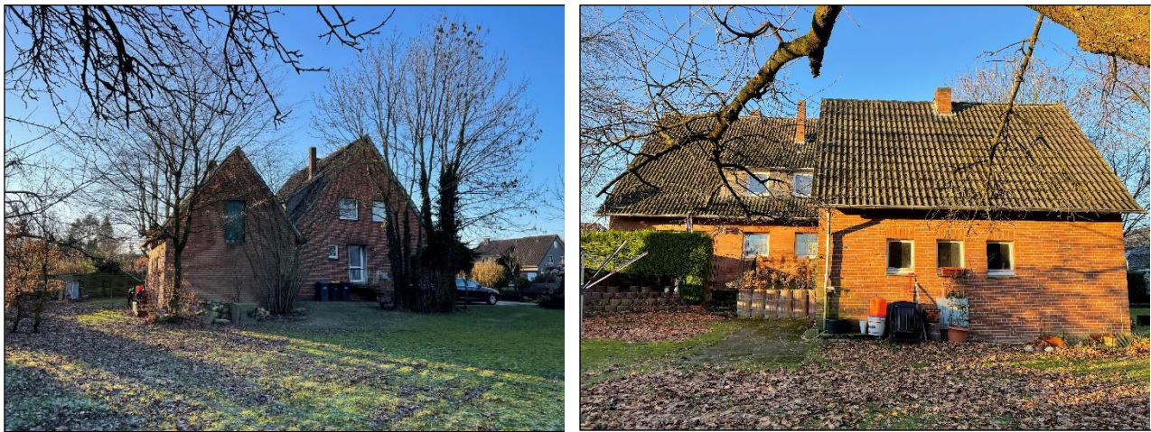
Abb. 3: Blick auf die abzureißenden Gebäude; Blick von Norden und Osten
