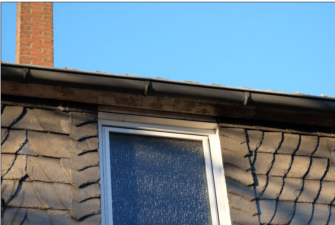
Abb. 9: Detailansicht der mit Schieferplatten gedeckten Gaube des Wohnhauses
