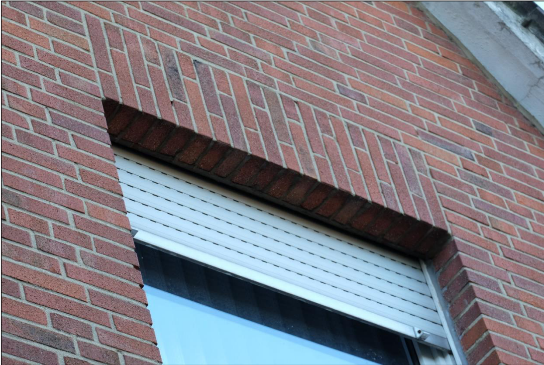
Abb. 8: Jalousiekasten an den Seitenfenstern des Wohnhauses
