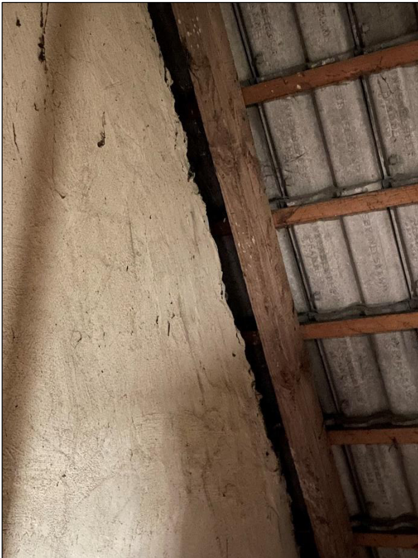
Abb. 14: Ungedämmter Dachboden des Nebengebäudes mit Nischen zwischen Dachstuhl und Giebel
