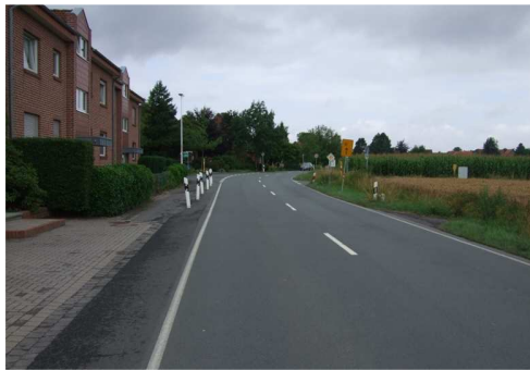
Havixbeckerstraße, Blick Richtung Nordwesten
