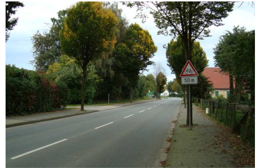
Gradliniger Straßenverlauf führt zu überhöhten Geschwindigkeiten
