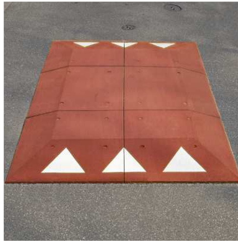
„Berliner Kissen“ provisorisch eingesetzt
