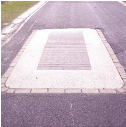
„Berliner Kissen“ baulich umgesetzt
