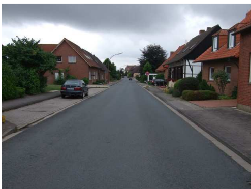
Fehlende Radverkehrsanlagen entlang der Hagenstraße (Nottuln)
