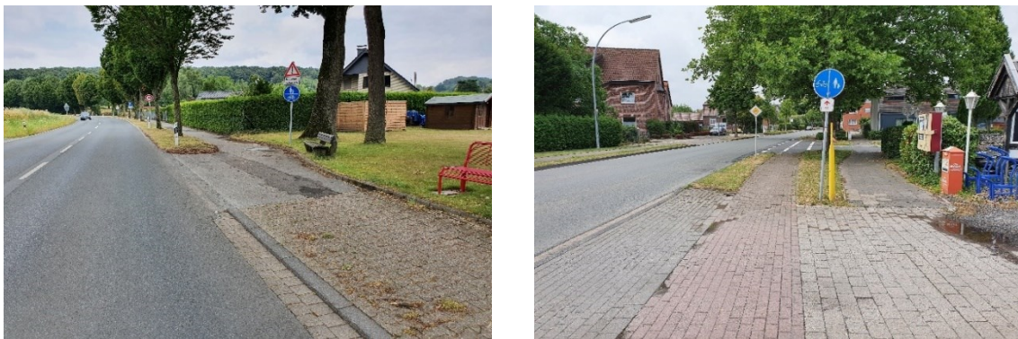
Abbildung 9: Mangelhafte Oberflächenqualität von Radwegen in Nottuln
