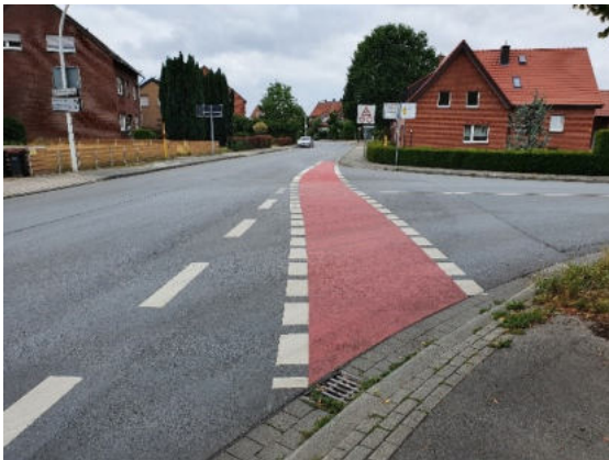
Abbildung 52: Einfädelungshilfe für den Radverkehr auf der Schapdettener Str.
