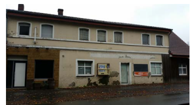
Abb. 057: Leerstand - ehem. Gaststätte am Ortseingang Coesfelder Str.
